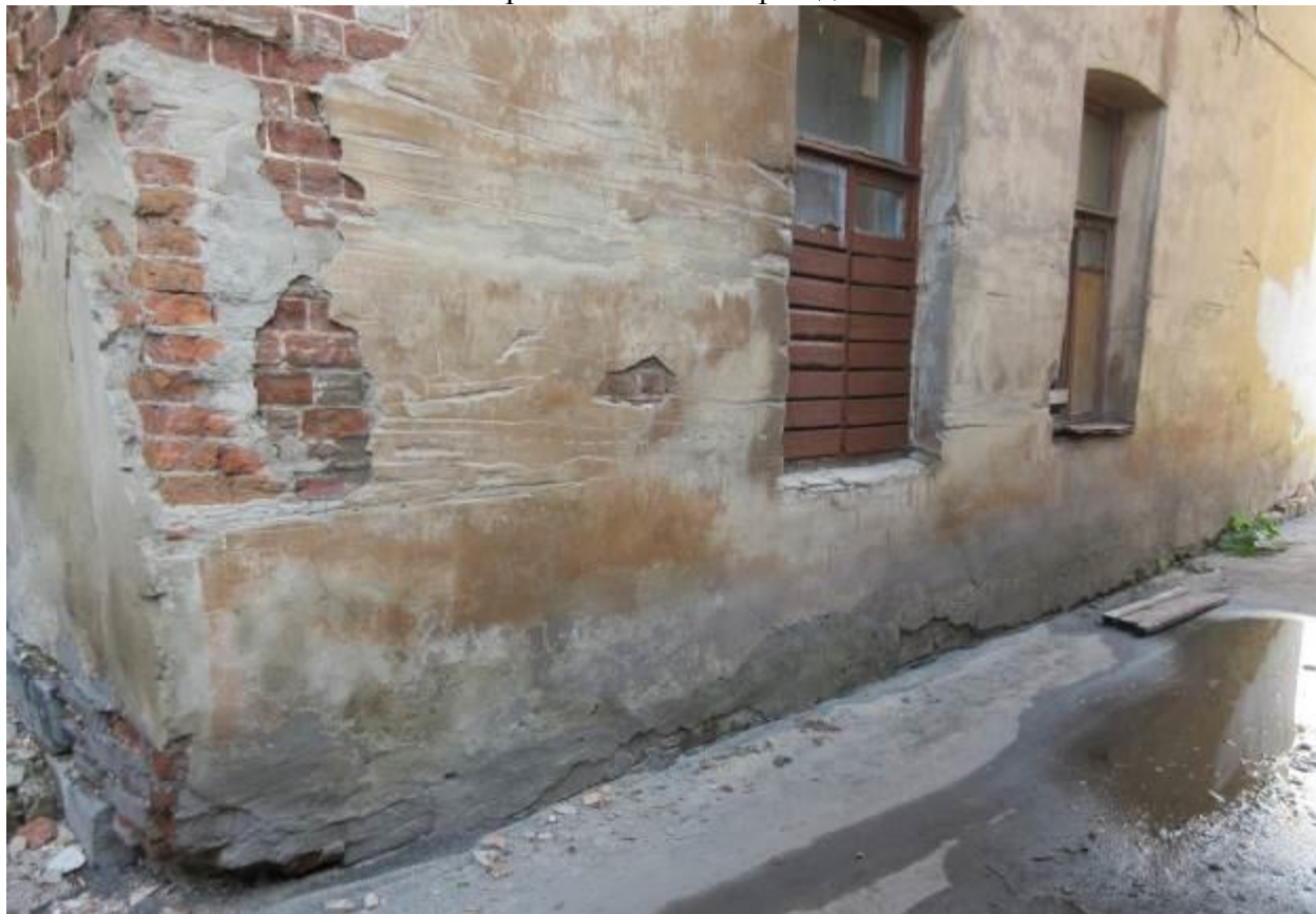
Фрагмент восточного фасада
