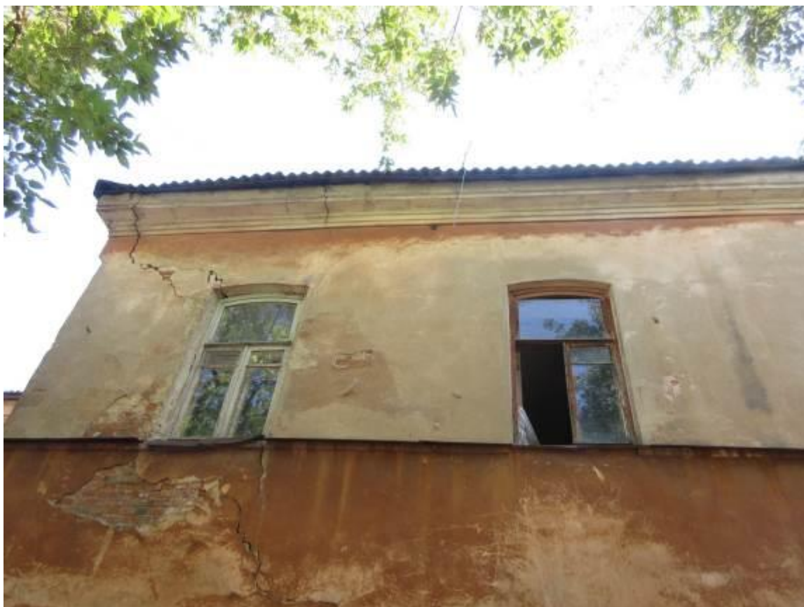
Фрагмент южного фасада
