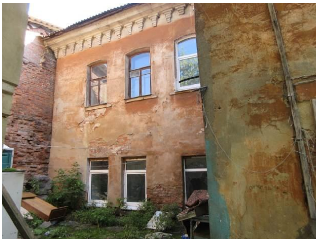
Фрагмент южного фасада
