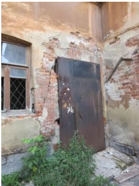
Фрагмент восточного фасада
